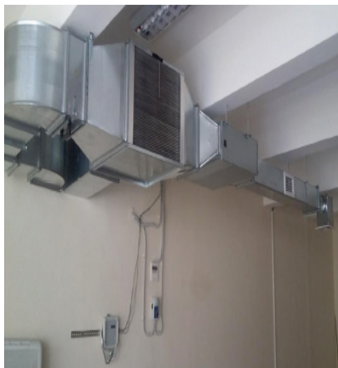
Фиг. 1. Общ вид на климатичната инсталация и контролни точки за измервания на температура на въздушните потоци и електрическа мощност на вентилаторите и хладилния компресор
